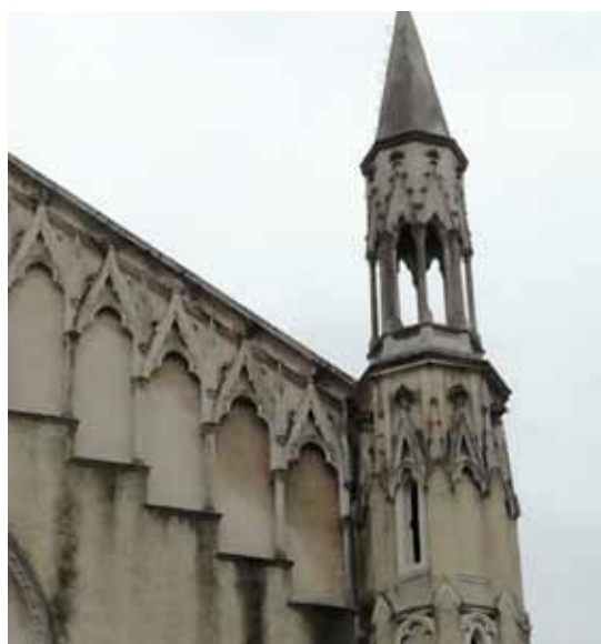
Particolare della facciata prossima ai lavori di pulitura
