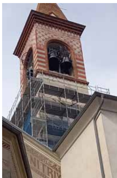
Completamento dei lavori di restauro del campanile.
