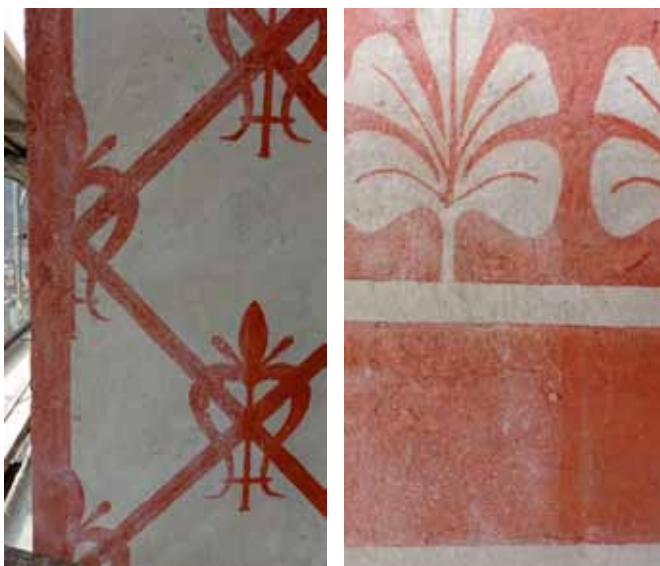
Campionature per l'armonizzazione dei colori e stesura del protettivo
