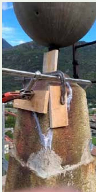
Riparazione della cuspid e fissaggio della scheggia con perni e collanti speciali
