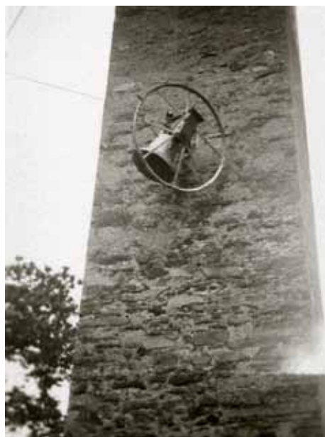
San Giorgio, posa in opera della campana.
